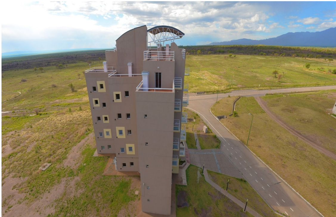
Vista exterior de las Residencias ULP
